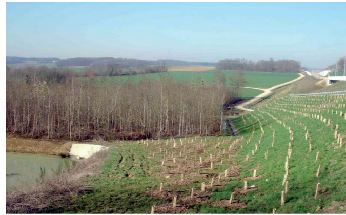
Insertion d'un bassin de rétention et de remblais d'accroche – Passage Grande Faune (PGF) des Rochets (77) - LGV Est – 2007
