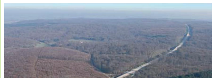
Traitement de lisières – Forêt de Benoîte-Vaux – Tronçon D – LGV Est - 2006
