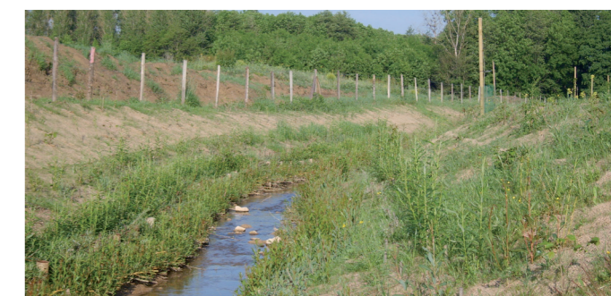
5 mois après les travaux de dérivation
