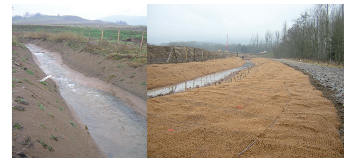
Photographie – Technique végétale sur cours d'eau En cours de travaux de dérivation et à la fin des travaux
