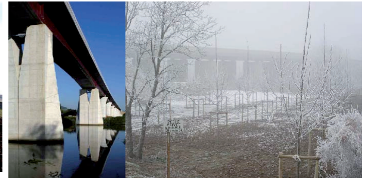
A gauche : viaduc de la Moselle LGV Est – 2007. A droite : plantation de bosquets d'essences hygrophiles en pied d'ouvrage d'art LGV Est – 2007
