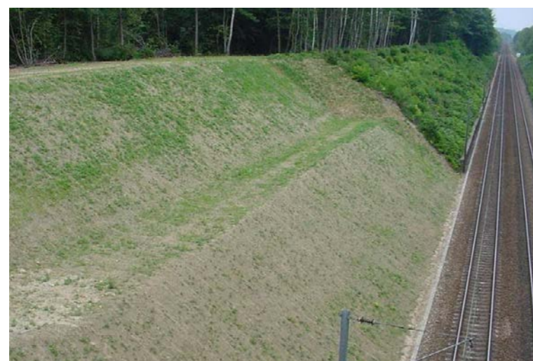
Grand déblai équipé d'une berme intermédiaire (source : RFF)
