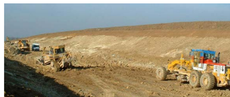
Réalisation d'un déblai - LGV Est Européenne (source : Inexia)
