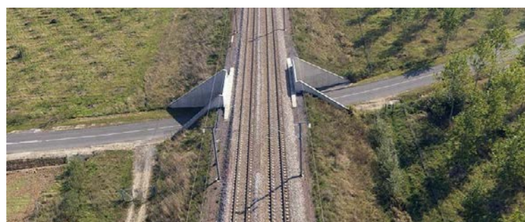
Ouvrage routier de type pont-rail (source : RFF - LGV Est)
