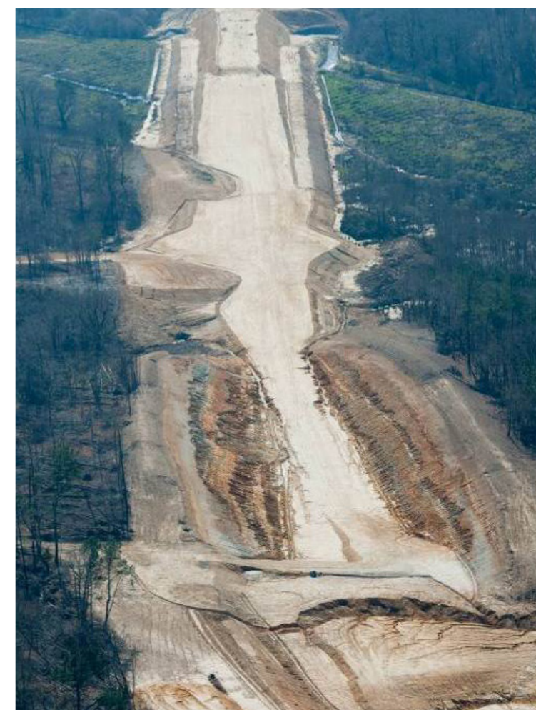
Travaux de terrassement du chantier de la RD85 à Tarnos [source : Egis rail, juin 2011]
