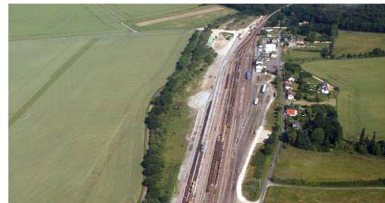
Base maintenance de Courtalain sur la LGV Atlantique [source : Inexia]
