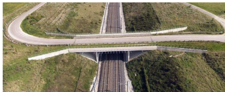
Ouvrage routier de type pont-route mixte (source : RFF - LGV Est)
