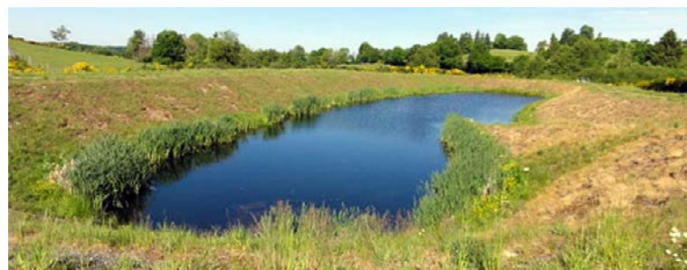
Bassin de recueil des eaux de plateforme (Source : Egis)
