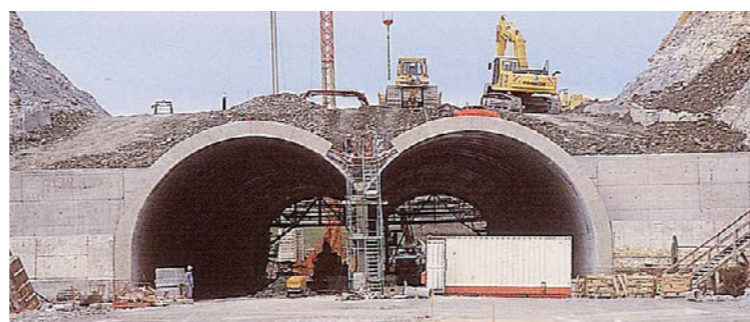
Exemple d'une tranchée couverte routière en phase travaux [source : Egis Tunnels]
