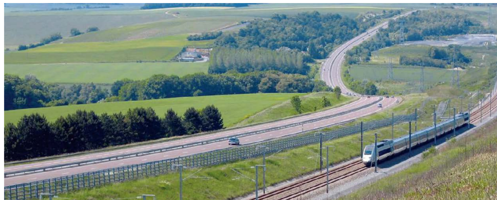
Jumelage LGV EE et autoroute A4 (source : Egis Rail)
