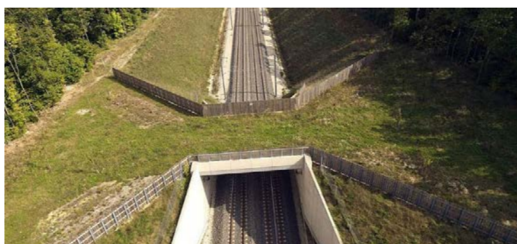
Passage grande faune de type pont-route (source : RFF - LGV Est)
